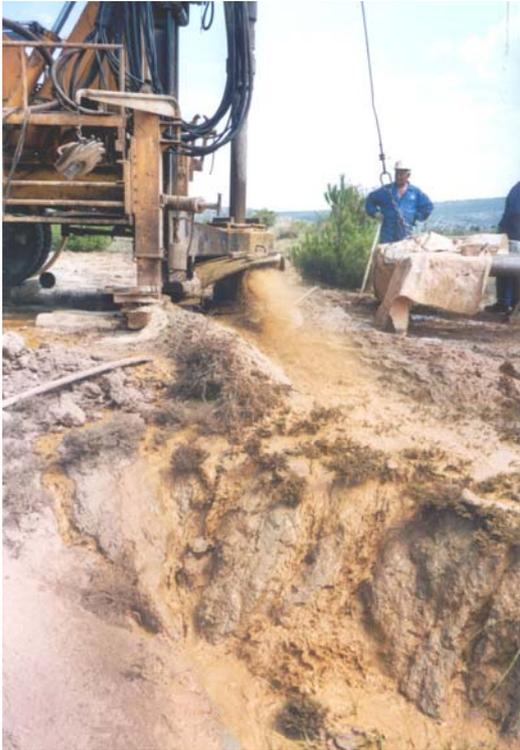
**Foto 1.-** Perforación del sondeo.
