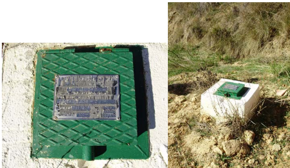
Foto 1 y 2.- Detalle del piezómetro 08.17.029.
