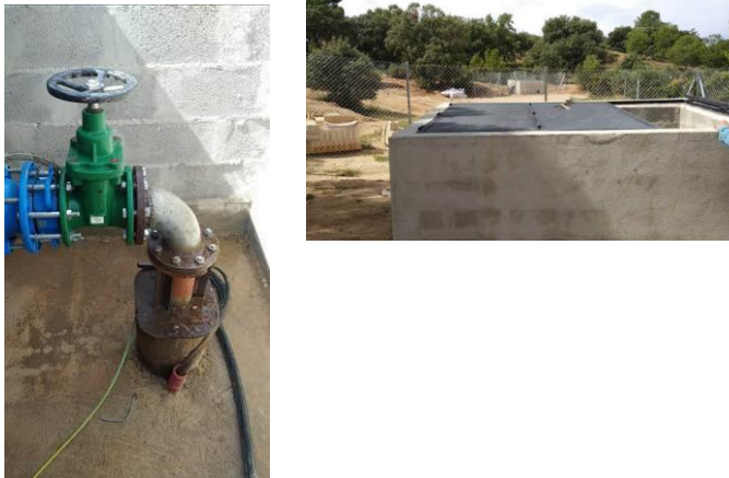
Figura 6. Sondeo Cañada Molina viejo. Al fondo, sondeo Cañada Molina nuevo
