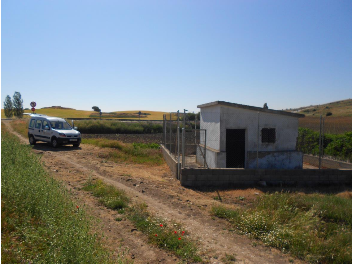
FOTO N° 3: Pozo El Tornajo
