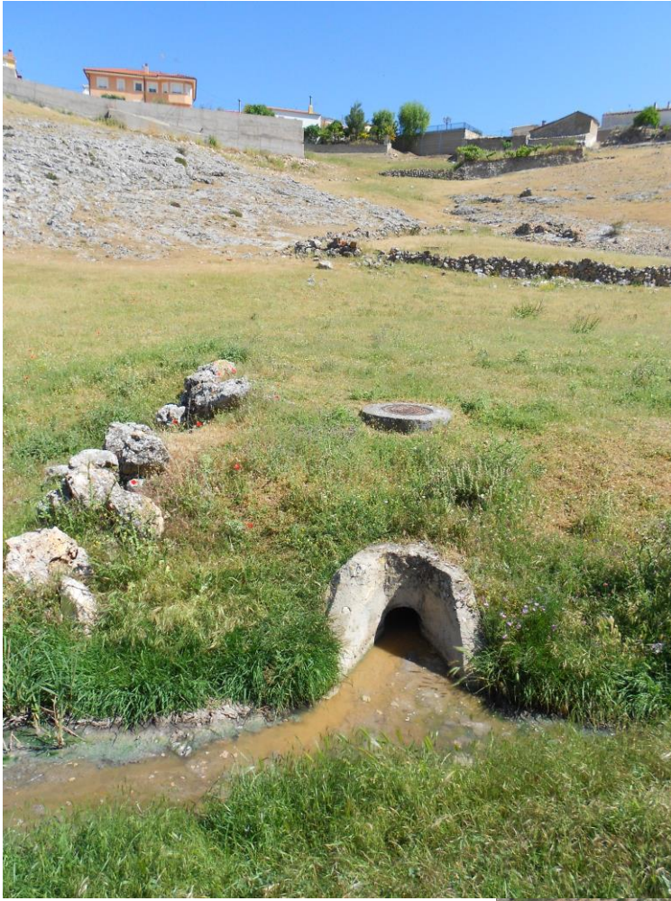
FOTOS nº 15 y nº 16: Punto de vertido de aguas residuales urbanas
