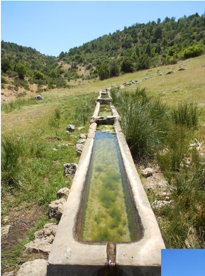
FOTOS nº 11 y nº 12: Fuente Villamar
