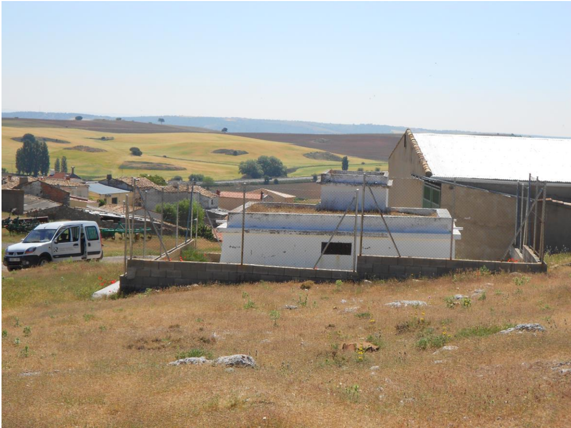
FOTO nº 9: Depósito de abastecimiento de Villar del Saz de Arcas
