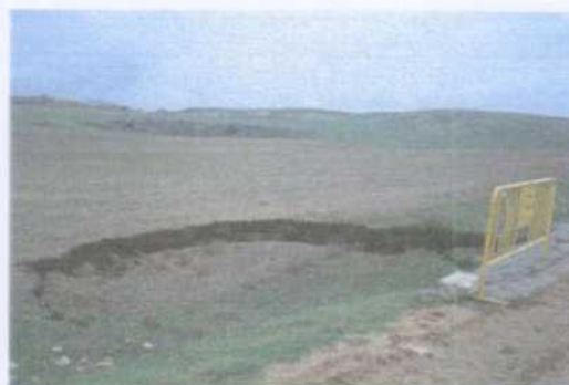
Fotos 2 y 3.- Hundimientos junto a la captación del INC (caseta situada a la izquierda) y detalle del mismo.
