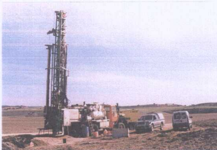
Foto 1. Perforación del sondeo de emergencia.
