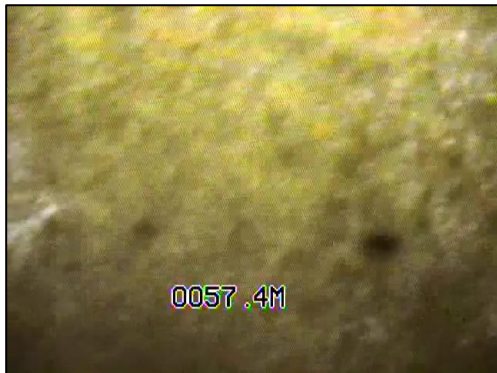
Figura 41. Tramo ranurado que no se observa por los óxidos.
