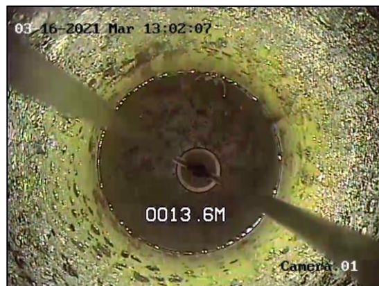
Figura 26. Nivel del agua. Se observa a mayor profundidad.
