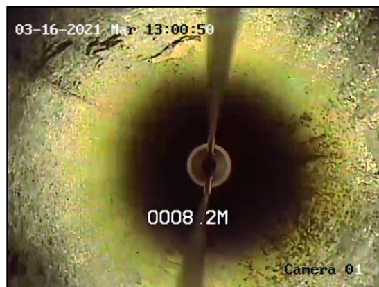
Figura 24. Tramo fuera del agua.
