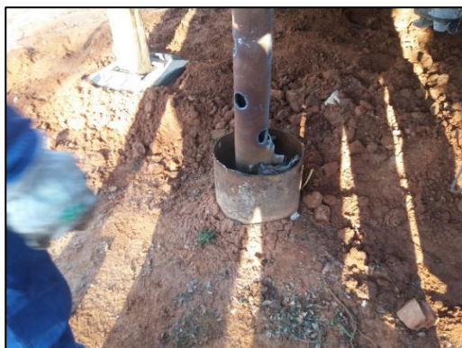
Figura 9. Inicio del cepillado en pozo.
