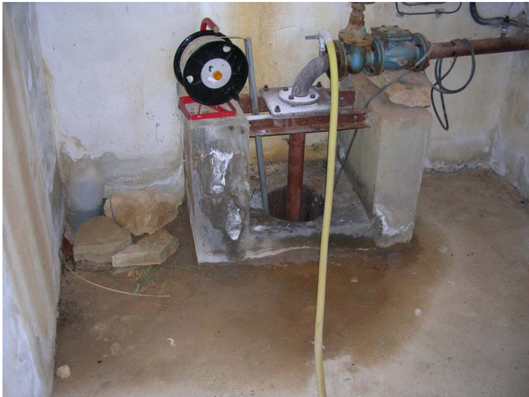
Foto 3- Detalle del Sondeo Valle.
