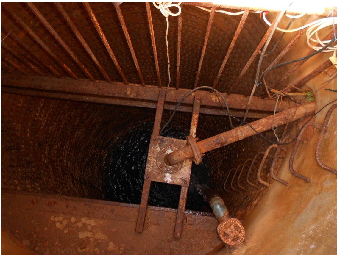
FOTO Nº 7: Vista interior del pozo San Antón
