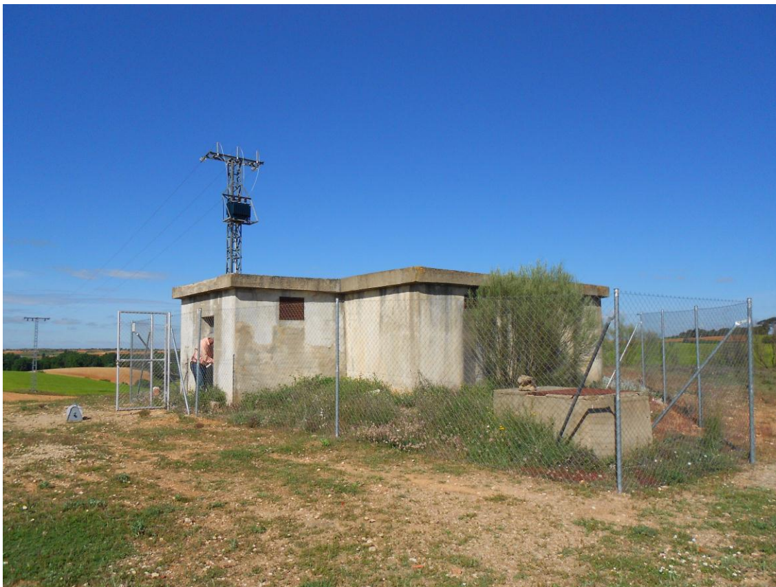
FOTO Nº 1: Depósito Vallejo de Don Juan y sondeo del mismo nombre
