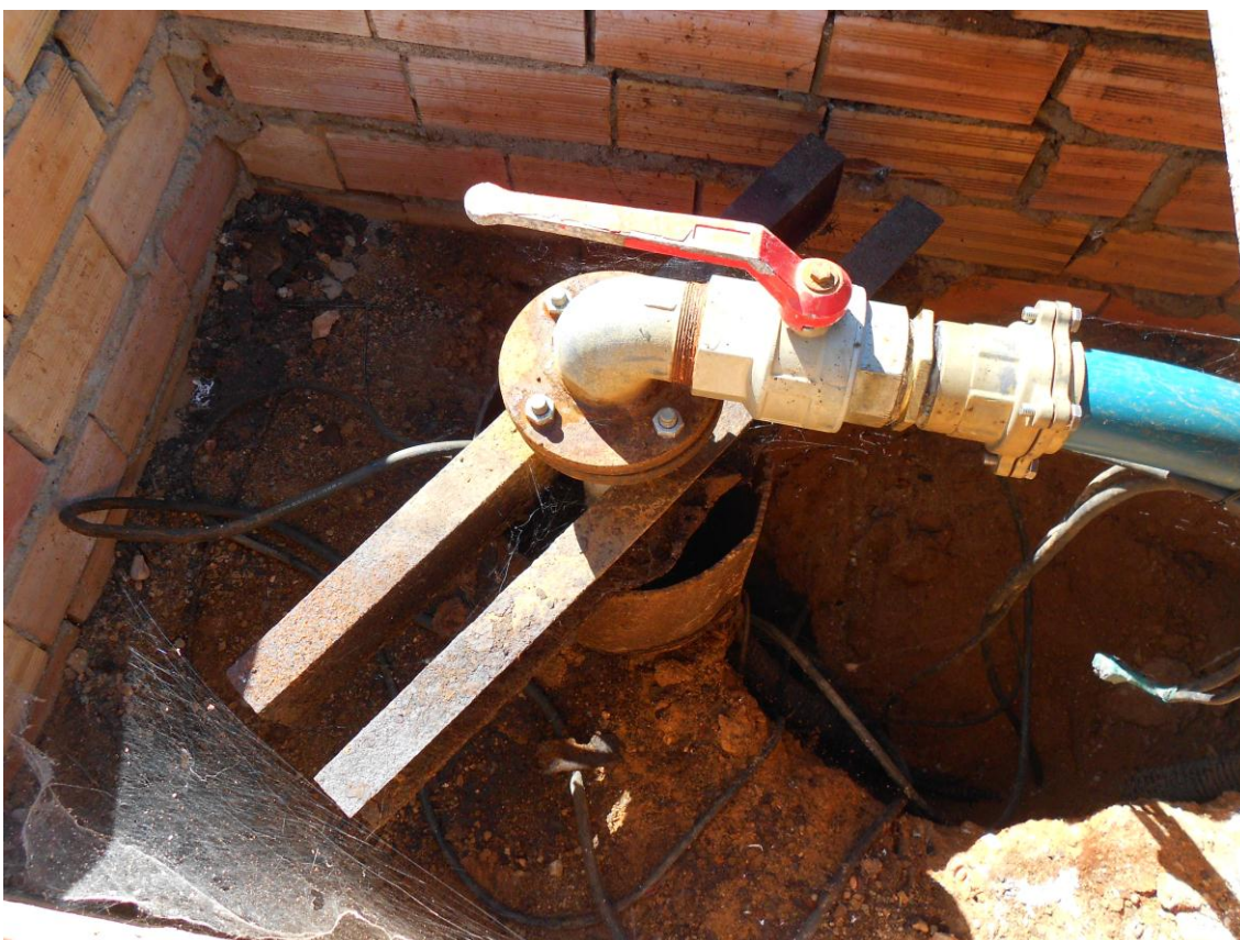
FOTO Nº 2: Detalle de la boca y la instalación del sondeo Vallejo de Don Juan
