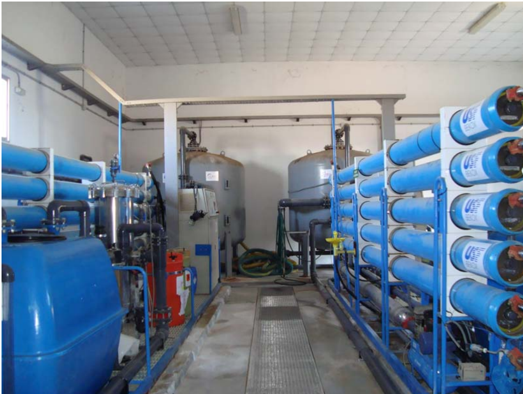
Foto 1.- Planta de tratamiento de agua de San Clemente.
