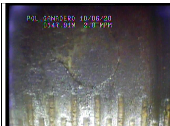
Fotografía 6.- Visión lateral. Ojal de colocación cerrado y comienzo del filtro.
