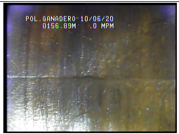
Fotografía 9.- Visión lateral. Posición del comienzo del segundo tramo de filtro Tipo "Puentecillo".
