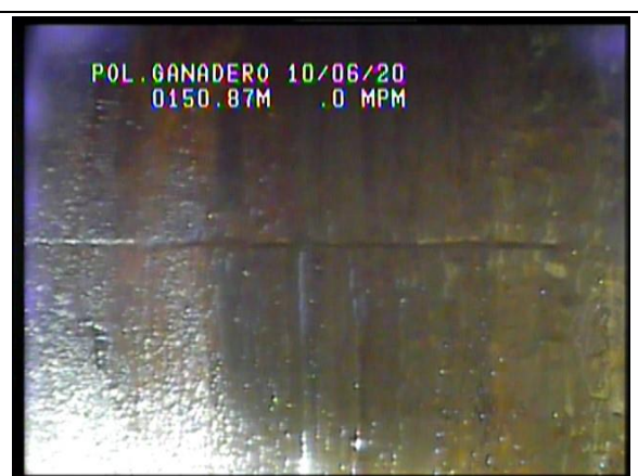
Fotografía 7.- Visión lateral. Posición del final del primer tramo de filtro.
