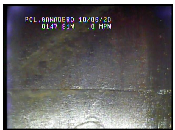
Fotografía 5.- Visión lateral. Detalle del comienzo del primer tramo de filtro de Tipo "Puentecillo".
