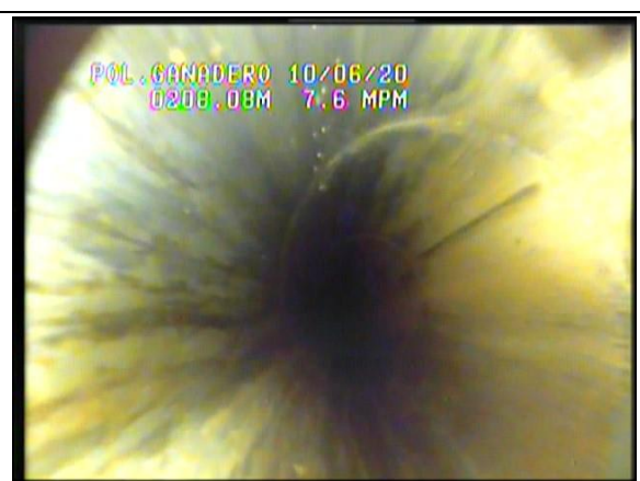
Fotografía 19.- Visión axial. Estado de la tubería de chapa de acero al carbono de 200 mm de soldadura helicoidal.
