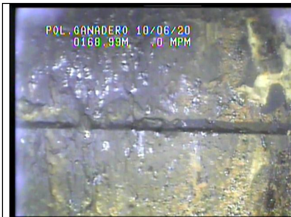
Fotografía 16.- Visión lateral. Final del tercer tramo de filtro Tipo "Puentecillo".
