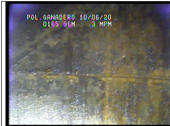
Fotografía 14.- Visión lateral. Posición del comienzo del tercer tramo de filtro Tipo "puentecillo"..
