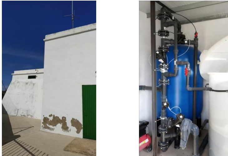
Figura 8. Depósito antiguo (izq.) y planta desnitificadora (dcha.)
