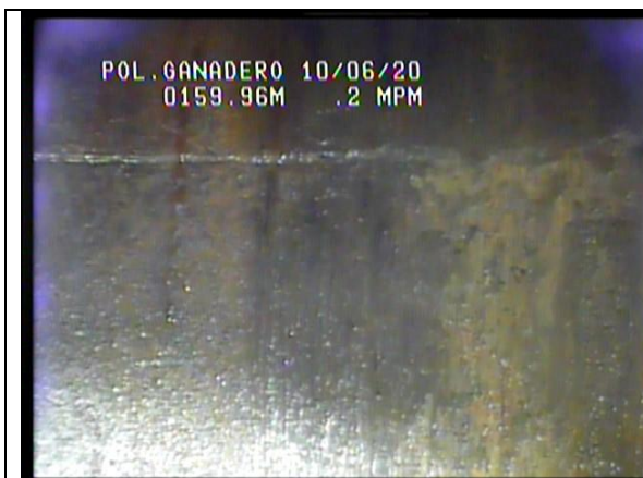
Fotografía 12.- Visión lateral. Final del segundo tramo de filtro de puentecillo.
