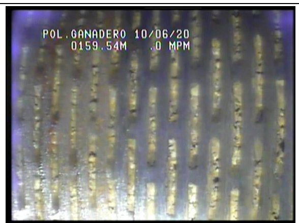
Fotografía 11.- Visión lateral. Aspecto del filtro Tipo "Puentecillo".
