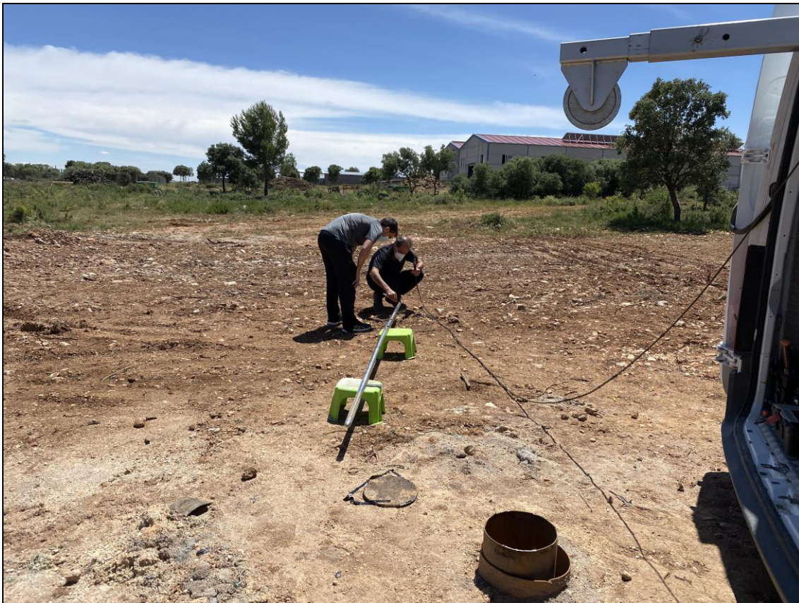
Fotografía 1.- Montaje de la cámara de sondas en el sondeo de la localidad de Campillo de Alto Huey.
