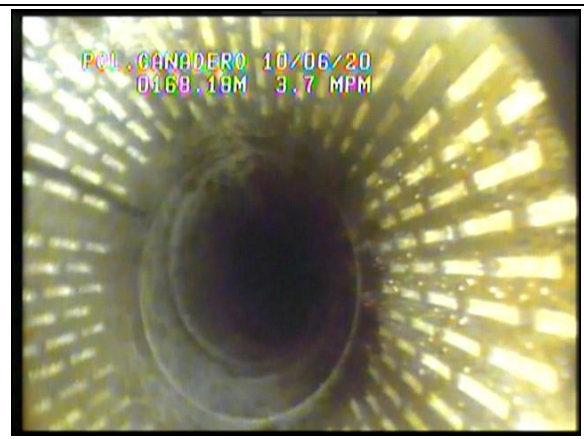
Fotografía 15.- Visión axial. Aspecto del estado del filtro Tipo "Puentecillo"..
