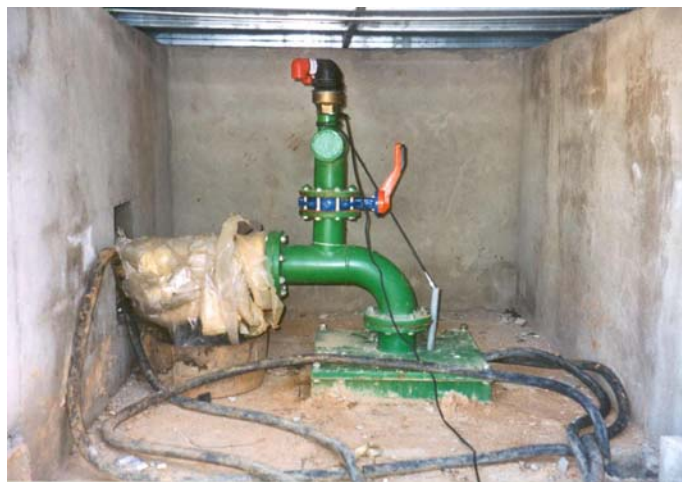
Fotos 1 y 2.- Captación de unos 22 m de profundidad y sondeo actual en Campillo de Altobuey.
