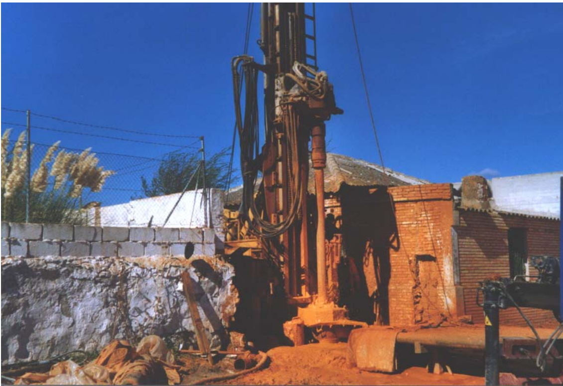
Fotos 1, 2. Perforación del sondeo definitivo. Obsérvese la angosta ubicación del sondeo.
