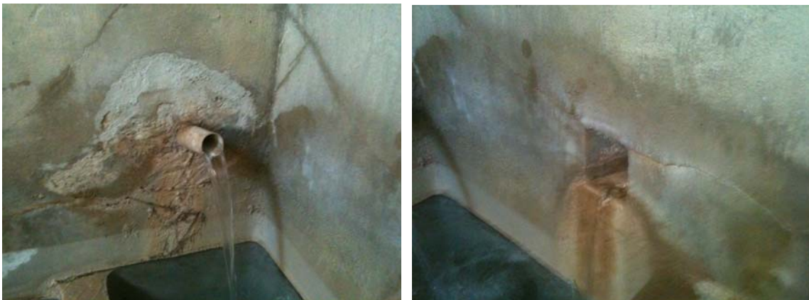
Fotografía 2. Detalle del punto donde vierten, respectivamente, los manantiales 1 y 2. dentro del depósito.
