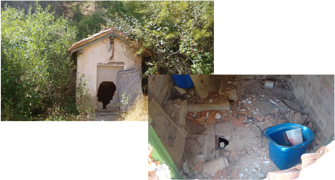
Figura 5. Captación de agua de Los Palancares
