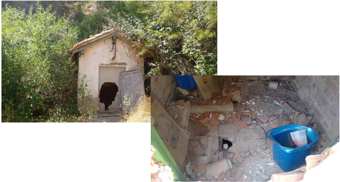
Figura 5. Captación de agua de Los Palancares
