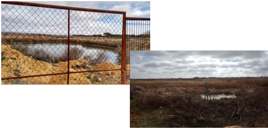
Figura 14. Balsas de infiltración de aguas residuales
