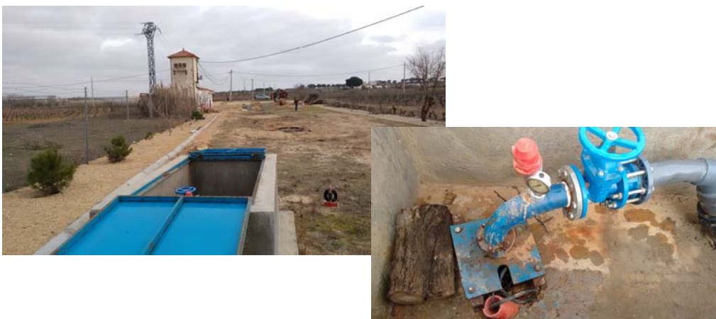
Figura 4. Sondeo de las Arenas
