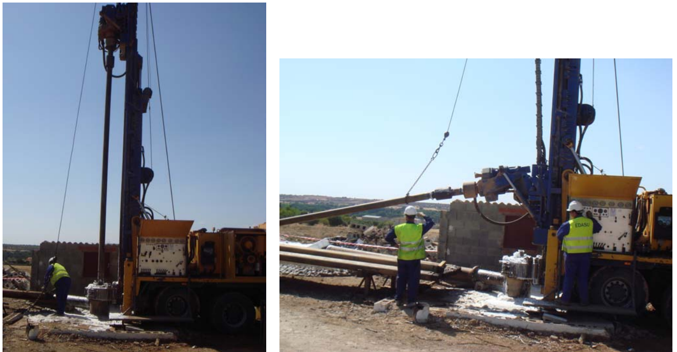
Fotografía 3. Maniobra de introducción de varillas.
