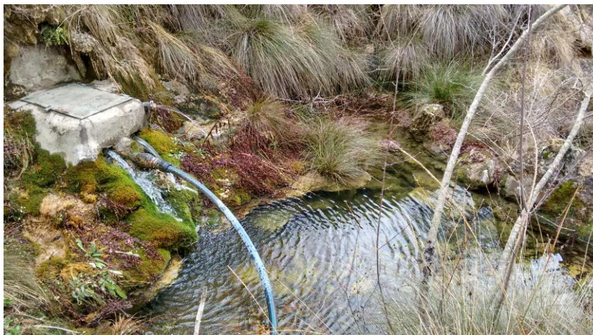
Figura 2. Arqueta de captación del manantial de arriba. Se observa la tubería que deriva el agua para abastecer y el caudal aliviado desde la arqueta.
