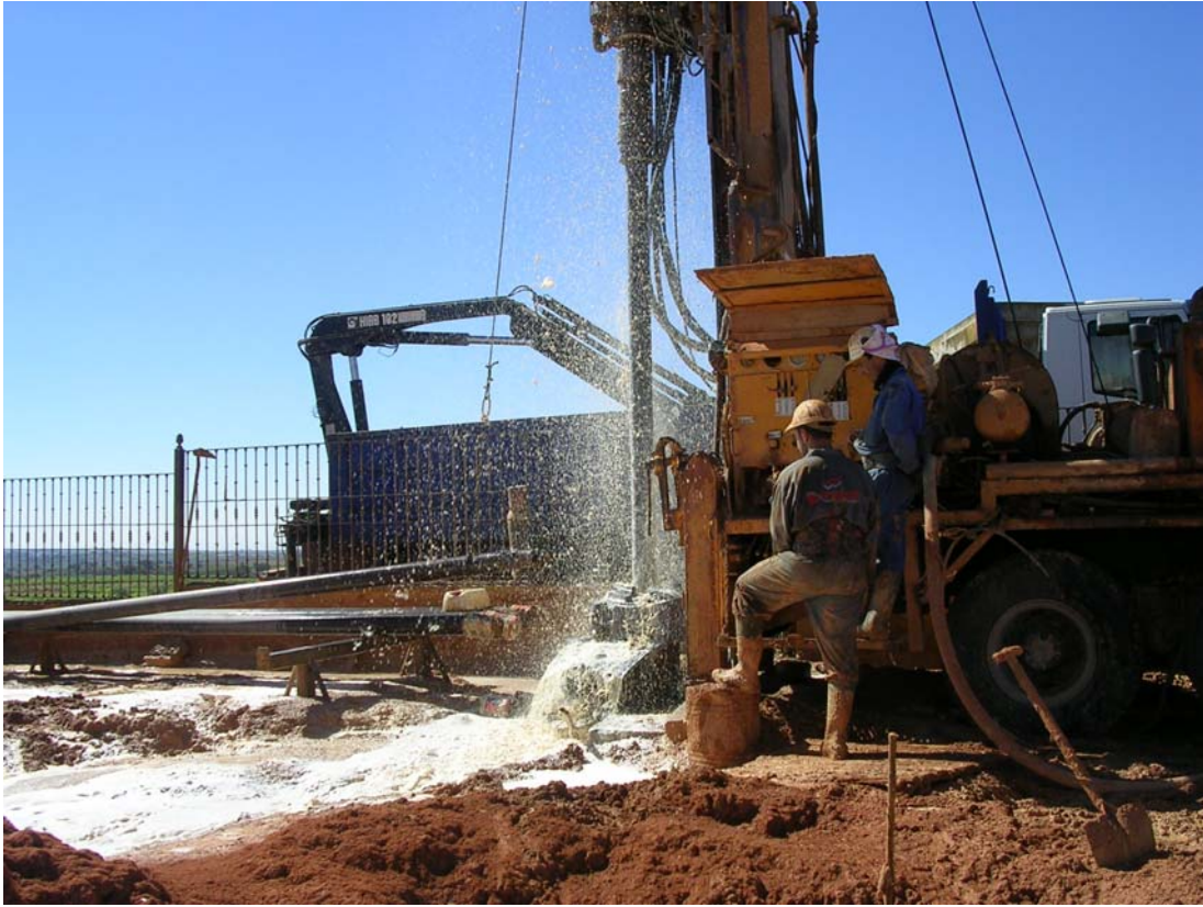
Foto 1- Vistas de la perforación de investigación con rotoperforación del sondeo HERRUMBLAR.
