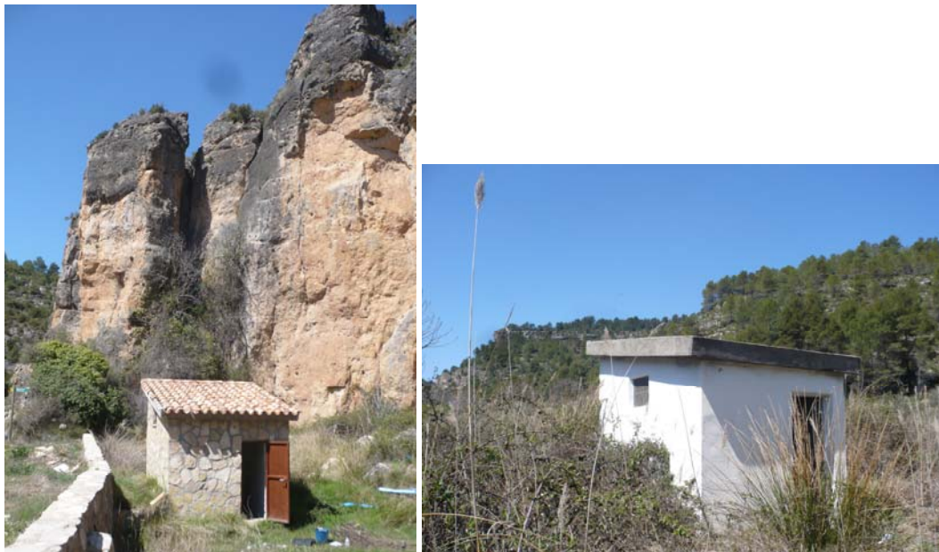
Figura 9. Fotos de las captaciones para abastecimiento de Enguídanos.
