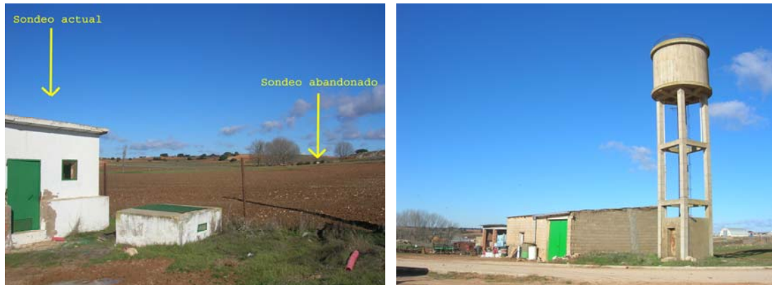
Fotos 1 y 2. Captaciones (actual y abandonada) y depósito
