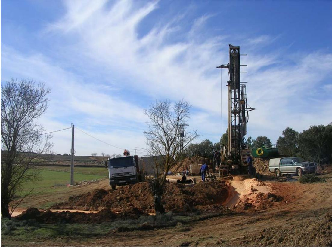
**Foto 1-** Vistas de la perforación de investigación con rotapercusión del sondeo GRAJA-2.
