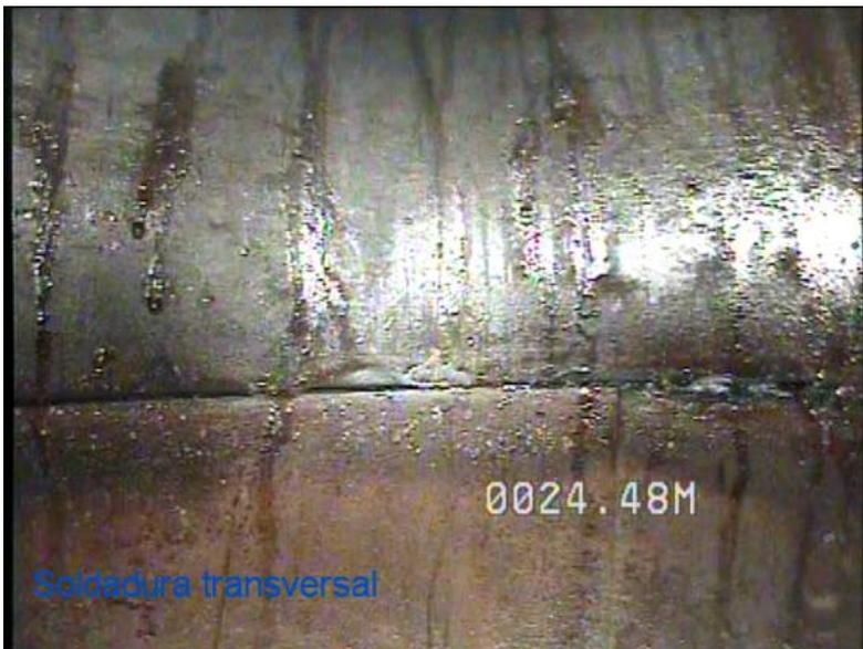
Soldadura transversal en buen estado, 24,48 m
