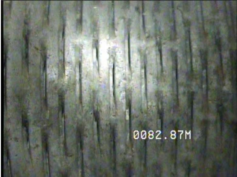
Detalle de filtro en buen estado, 82,87 m
