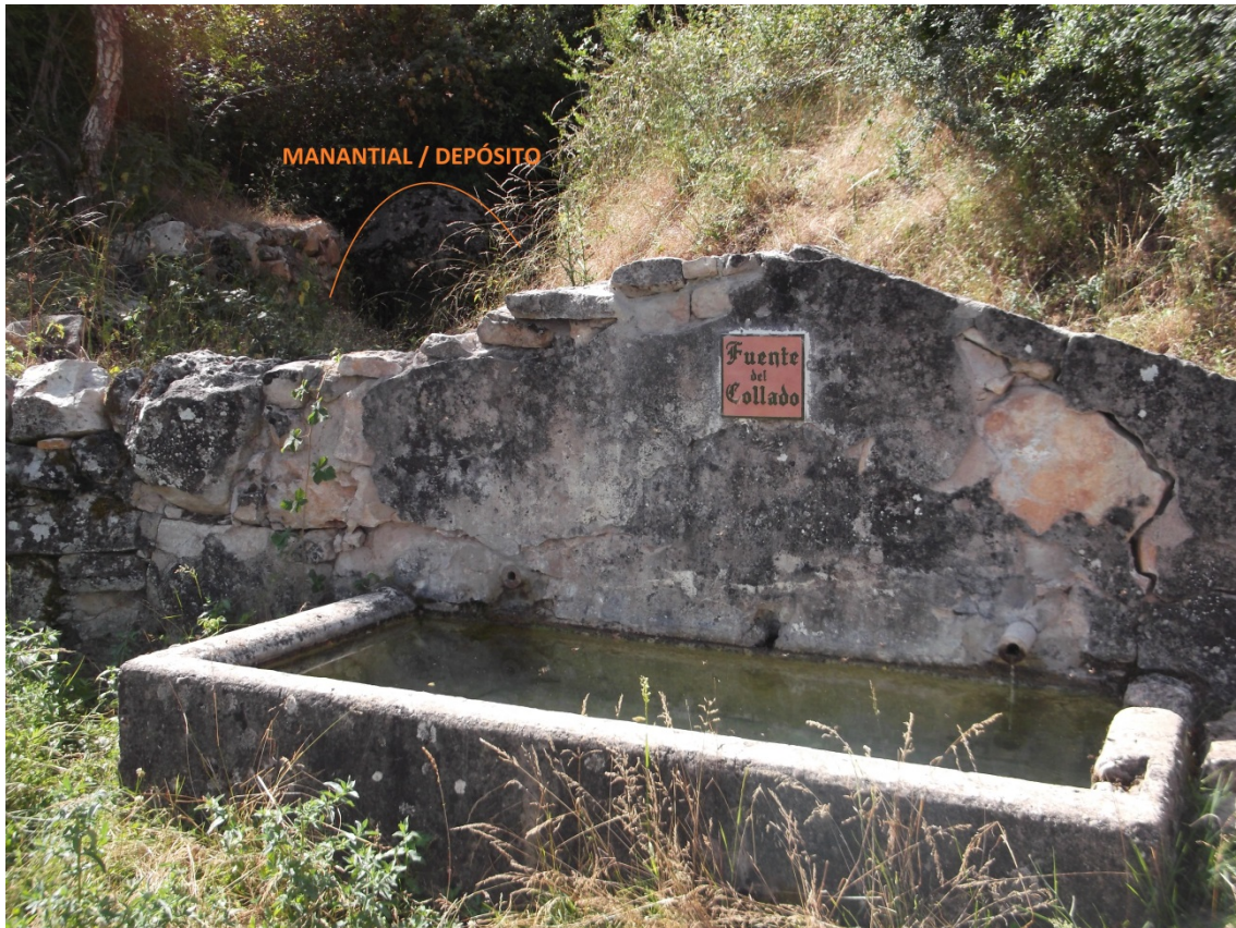
Figura 11. Manantial / Depósito y Fuente del Collado (foto: C. Camuñas).
