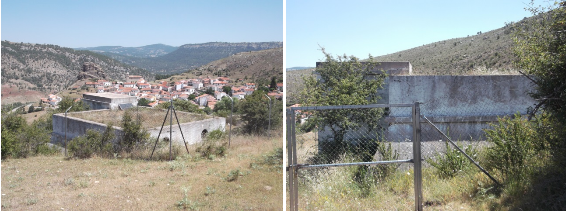
Figura 7. Depósito de abastecimiento a la localidad de Huélamo (fotos: C. Camuñas).
