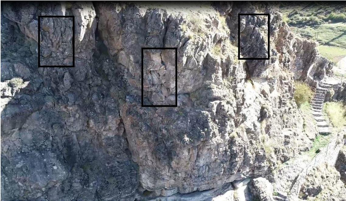
*Figura 34. Fotografía de la parte occidental del escarpe en el que se observa una fractura subvertical que atraviesa todo el macizo y las áreas que presentan bloques sueltos con posibilidad de caída.*
