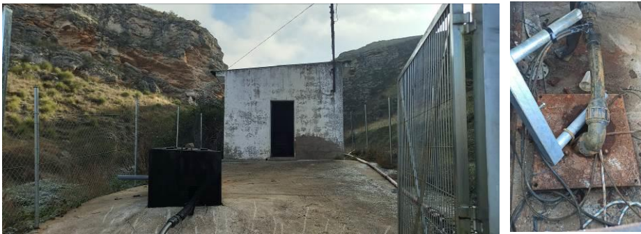
Figura 3. Sondeo de abastecimiento de Huelves
