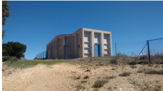
Figura 10. Depósito de Verdelpino
