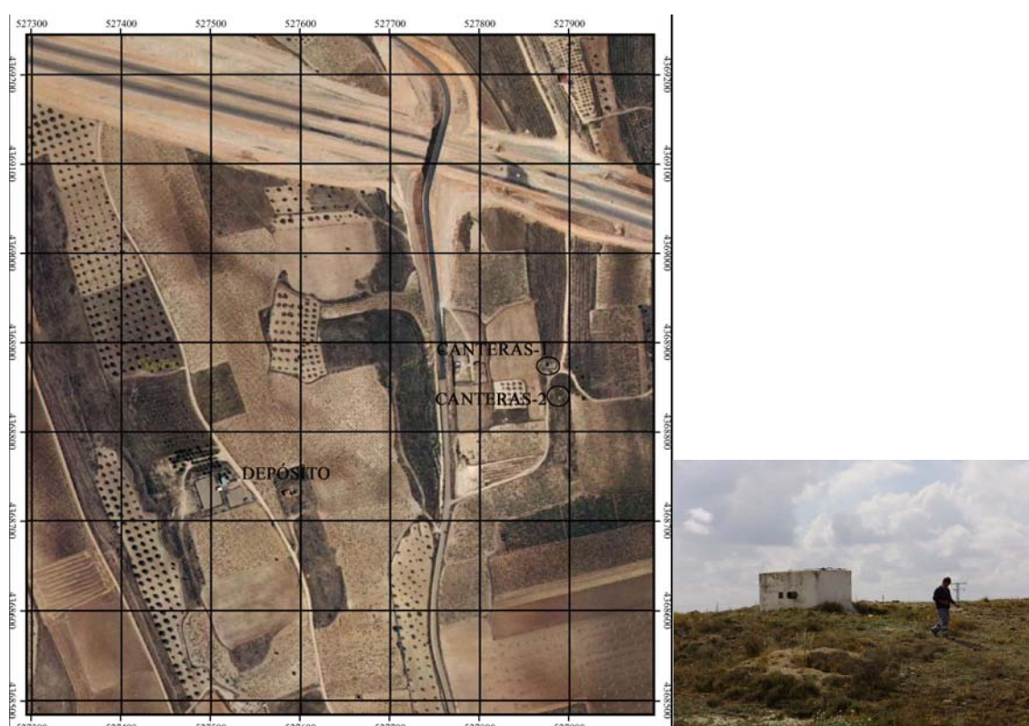
Foto 1. Vista de la captación Canteras-2 en Las Pedroñeras y vista aérea de ambas captaciones y del depósito.
