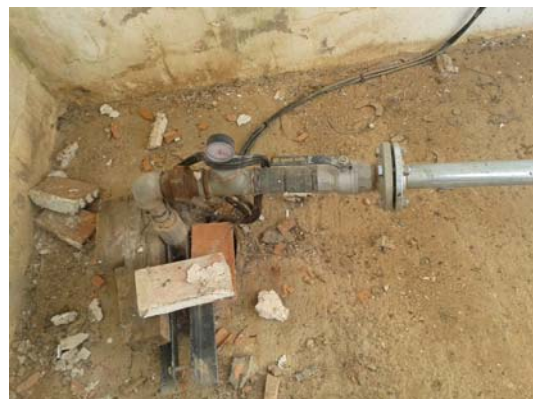
Sondeo de abastecimiento actual a Parra de las Vegas
