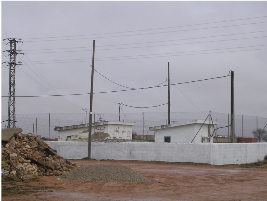
Figura 10. Captación de Ledaña con vallado de restricciones absolutas.
