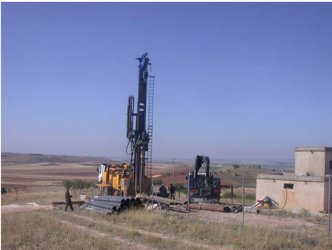
Figura 1- Vistas de la perforación del sondeo Monreal-1
