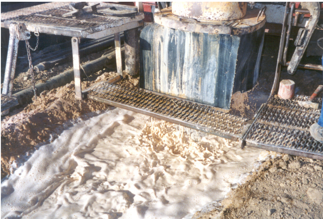
Fotos 1 y 2.- Ubicación del sondeo perforado y detalle del caudal de agua.
