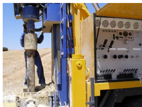
Fotos 1 y 2. Perforación a rotopercusión del sondeo PINAREJO-1
