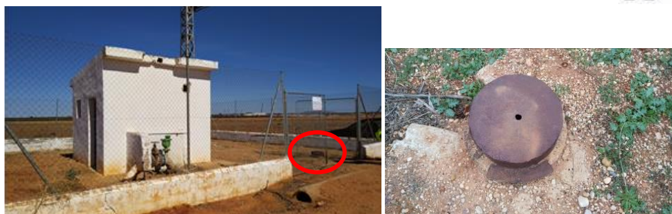
Figura 3. Sondeo abandonado al lado del sondeo Calderones
