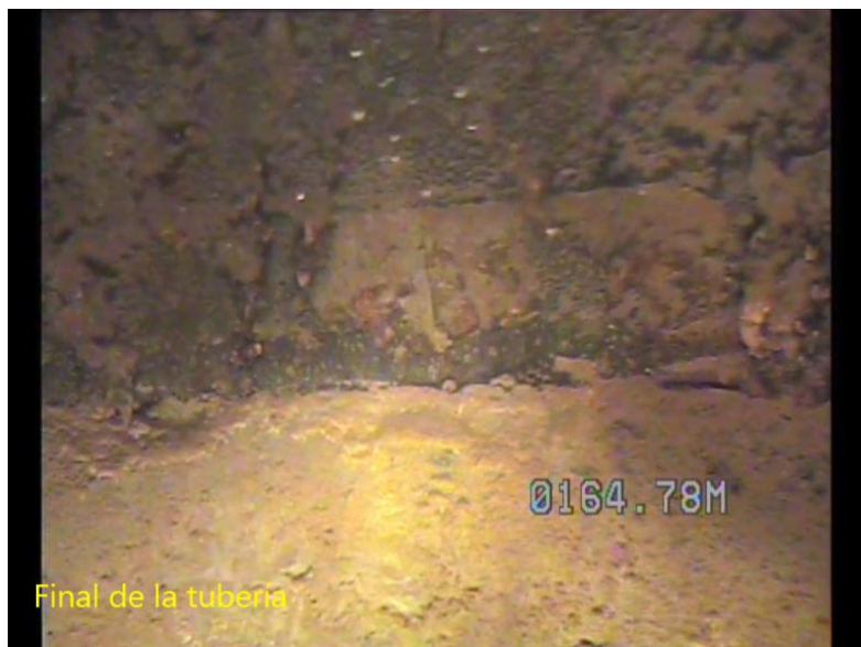
Final de la entubación, 164,78 m
