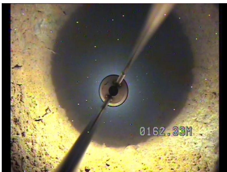
Incrustaciones y precipitados carbonatados, 162 m
