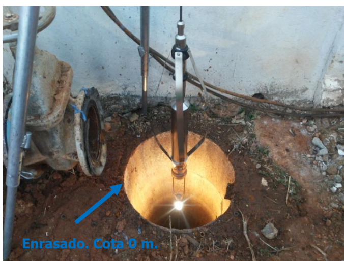
Fig. 5. Fotografía del brocal del sondeo.
