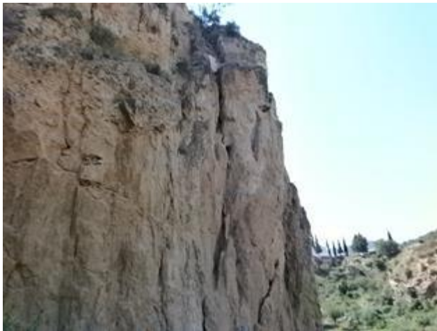
Vista del macizo rocoso con grietas.
