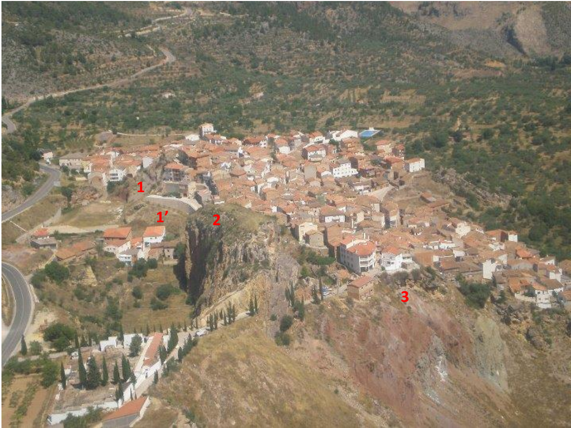
Figura 19. Vista del núcleo urbano desde el sur. 1) Laderas con problemas de estabilidad al oeste del pueblo que han causado daños en viviendas; 2) Peña del Castillo; 3) laderas situadas al sur con problemas de estabilidad superficial que causan daños en pavimentos de calles (Foto tomada de la pg. web del Ayto. de Santa cruz de Moya)
