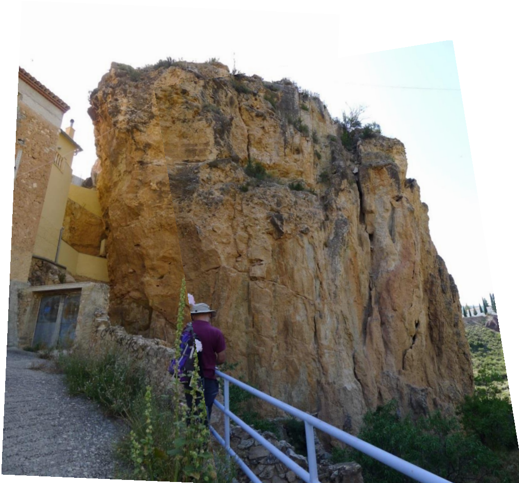
Figura 20. Vista del extremo norte de la Peña del Castillo, desde la calle Salida Landete. A la izquierda, pintada en amarillo, la vivienda sobre la que cayeron grandes bloques en julio de 2013, desprendidos desde la parte más alta. Tanto en el frente como hacia la parte izquierda pueden observarse grandes grietas verticales de tracción que aparecen abiertas, independizando lajas o bloques con peligro de desprendimiento. La presencia de planos de discontinuidad horizontales ayuda a independizar estos grandes bloques por su base.
