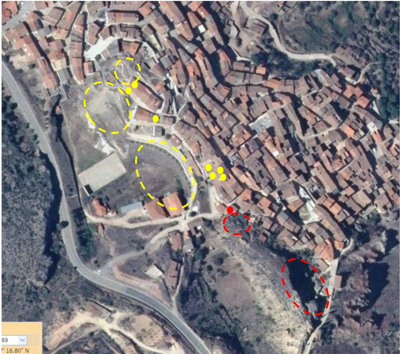
Figura 30. Sobre la fotografía aérea (SIGPAC) se han marcado con puntos amarillos las viviendas con daños por grietas que se visitaron, y con un punto rojo la vivienda afectada por los desprendimientos rocosos en julio de 2013. Con líneas discontinuas aparecen indicadas las principales zonas de inestabilidad por deslizamiento de laderas (amarillo) y por desprendimientos de bloques rocosos (rojo).
