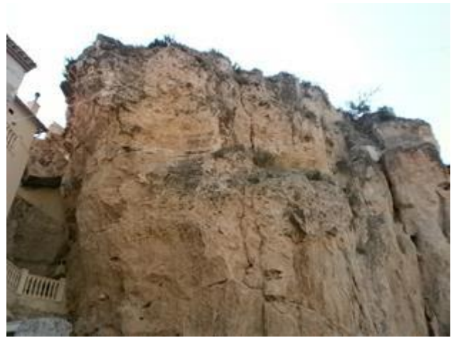
Vista del macizo rocoso junto a la vivienda.
