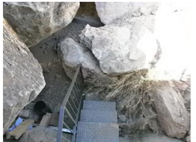
Forjado existente con fragmentos de roca.
