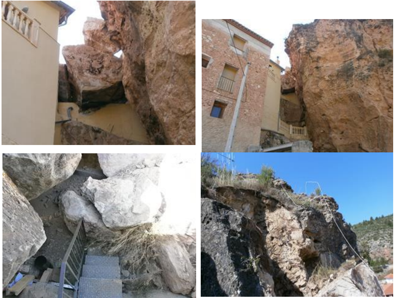
Figura 17. Grandes bloques rocosos desprendidos y caídos sobre una vivienda en la c/ Castillo 2 (arriba); bloques caídos sobre el patio y escalera (abajo izda); zona del macizo donde se desprendieron los bloques, por encima de la vivienda (abajo dcha). (Fotografías tomadas del documento de la Diputación de Cuenca incluido en el Anexo)
