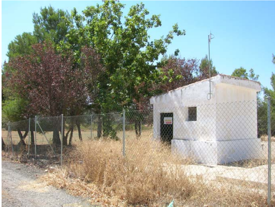
Figura 14. Captación de Sisante con vallado de restricciones absolutas.
