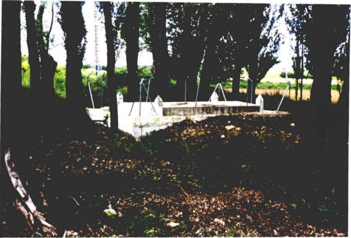
Foto 1- Manantial de Fuenterrredonda, empleado para el abastecimiento a Uclés. Se observa a la izquierda la tubería de goma negra usada para traer el agua de un sondeo cercano particular.
