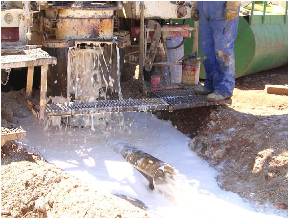
Fotos 1 y 2.- Perforación del sondeo de Valhermoso de la Fuente.
