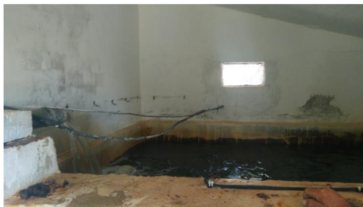
Figura 3. Caudal de entrada al depósito del sondeo 1
