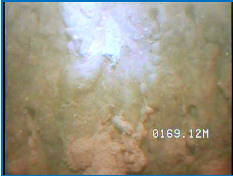
Detalle filtro troquelado con incrustaciones, 169,12 m
