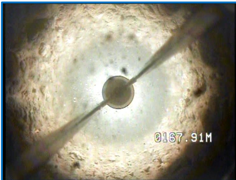
Detalle filtro troquelado con incrustaciones, 167,91 m
