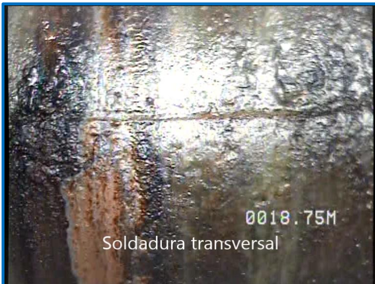
Detalle soldadura transversal, 18,75 m
