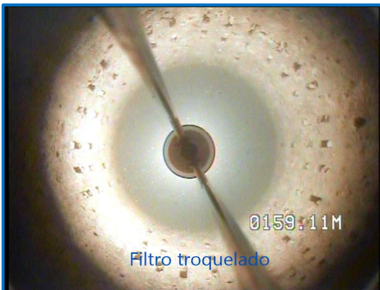
Filtro troquelado, visto desde 159,11 m
