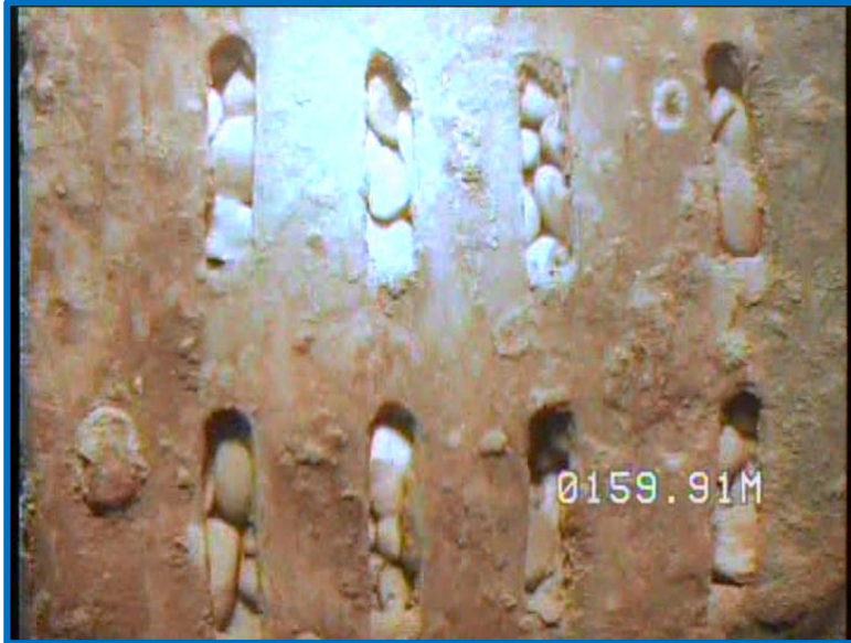
Detalle filtro troquelado, 159,91 m
