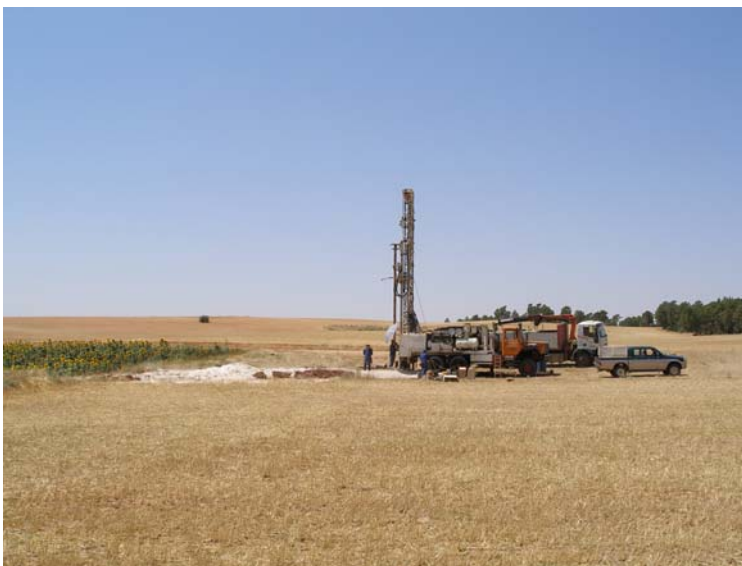
Foto 2. Vista de la perforación del sondeo VALVERDEJO-IV
