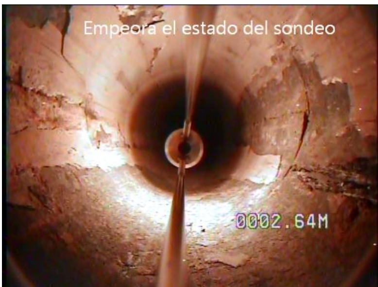
Estado de la entubación, 2,64 m
