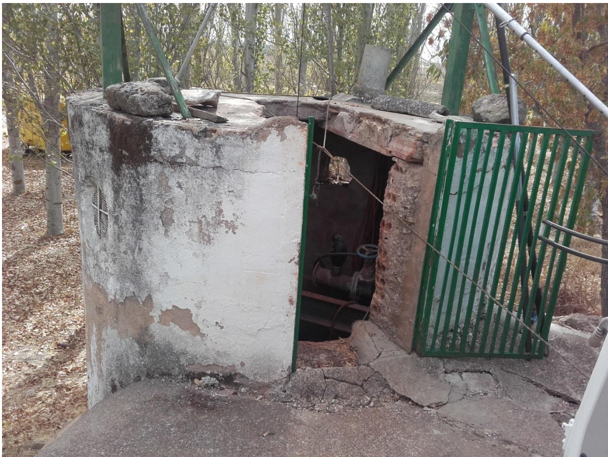
Fotografía del brocal del sondeo.
