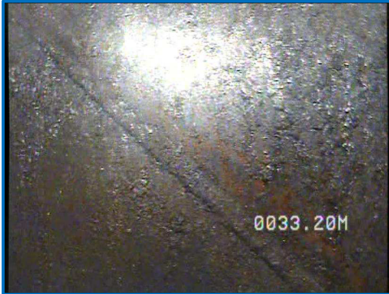
Detalle de la soldadura helicoidal, 33,20 m
