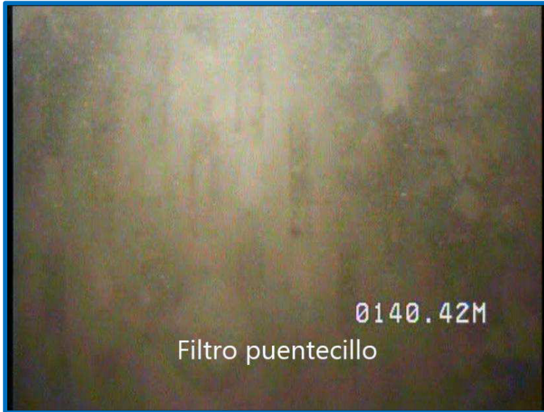
Detalle de filtro puentecillo, 140,42 m
