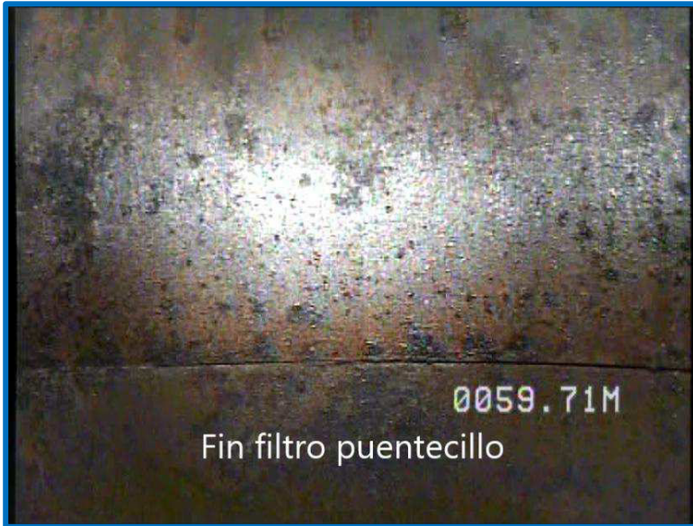
Fin filtro puentecillo 1, 59,71 m
