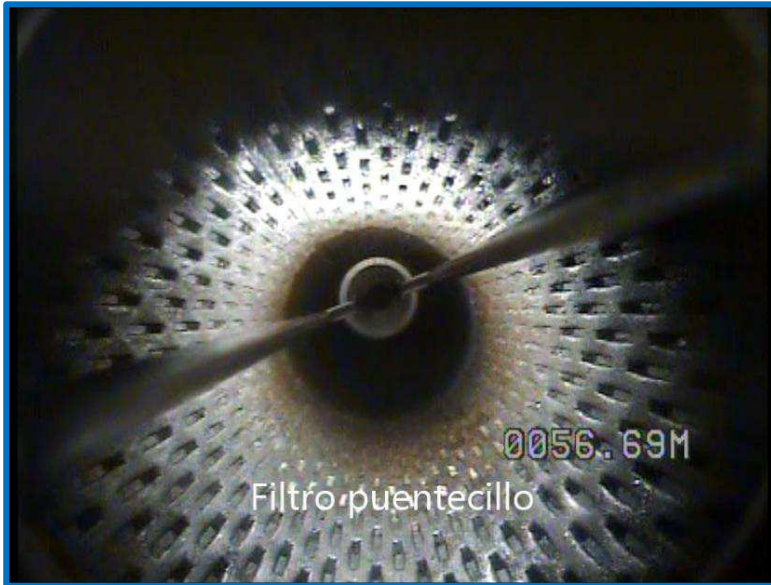
Inicio filtro puentecillo 1, 56,69 m
