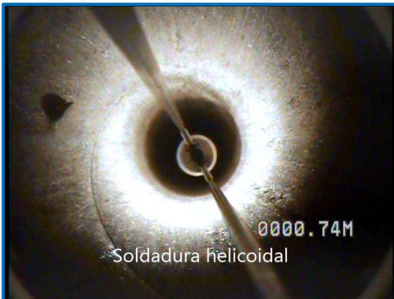
Tubería tipo soldadura helicoidal, 0,74 m
