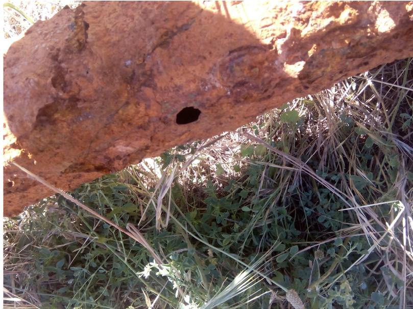
Foto 1.\_ Tubería de impulsión perforada.
