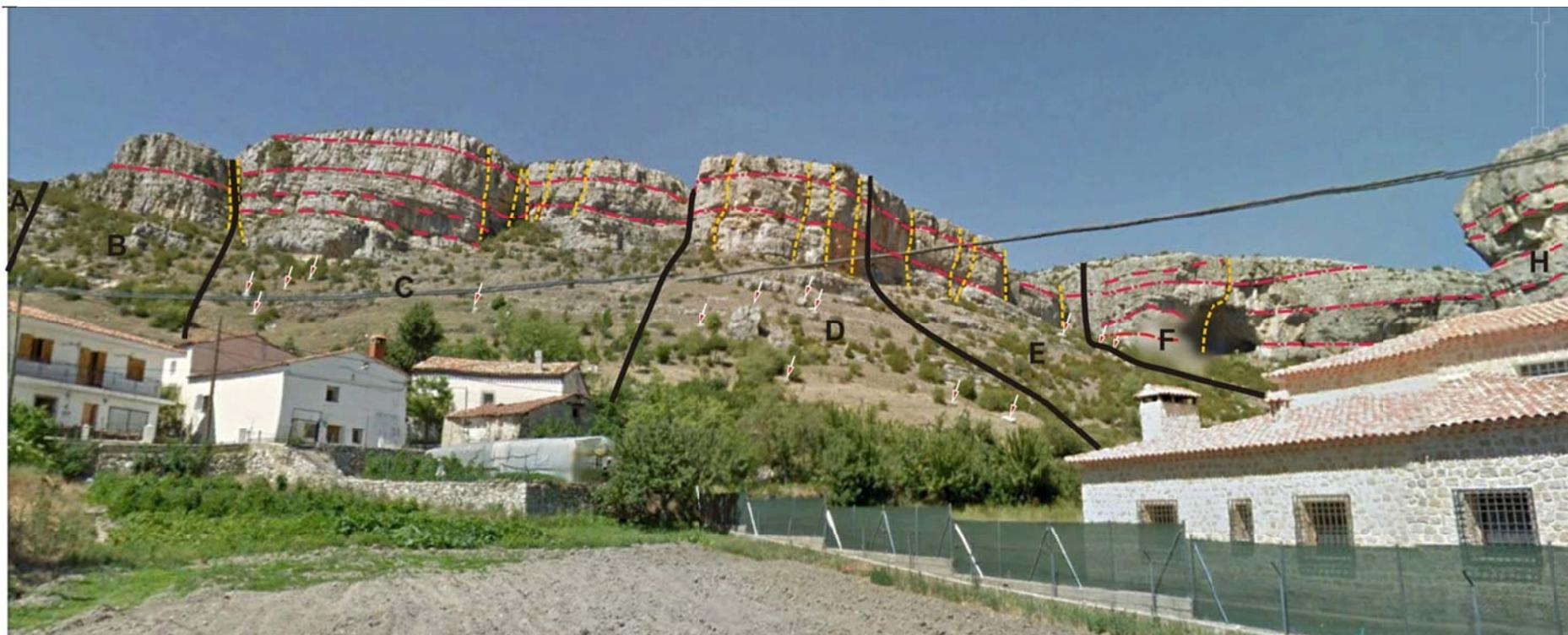
Figura 15. Vista general de la ladera N del Barrio de La Cueva con representación de los límites de las zonas de desprendimientos (en negro), las trazas de las principales fracturas que atraviesan todo el escarpe (en punteado amarillo) y la situación de los estratos de potencia menor y más erosionables que delimitan la estructura sedimentaria del escarpe (en naranja discontinuo). Se han marcado con flechas rojas la situación de los bloques caídos más grandes observados en la ladera.
