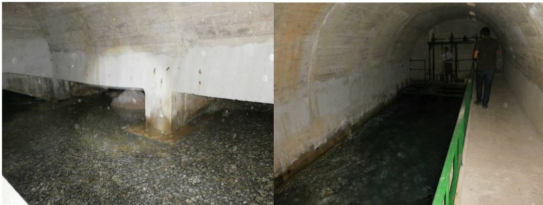
Figura 10. Detalle de grutas y del depósito de abastecimiento de Cuenca
