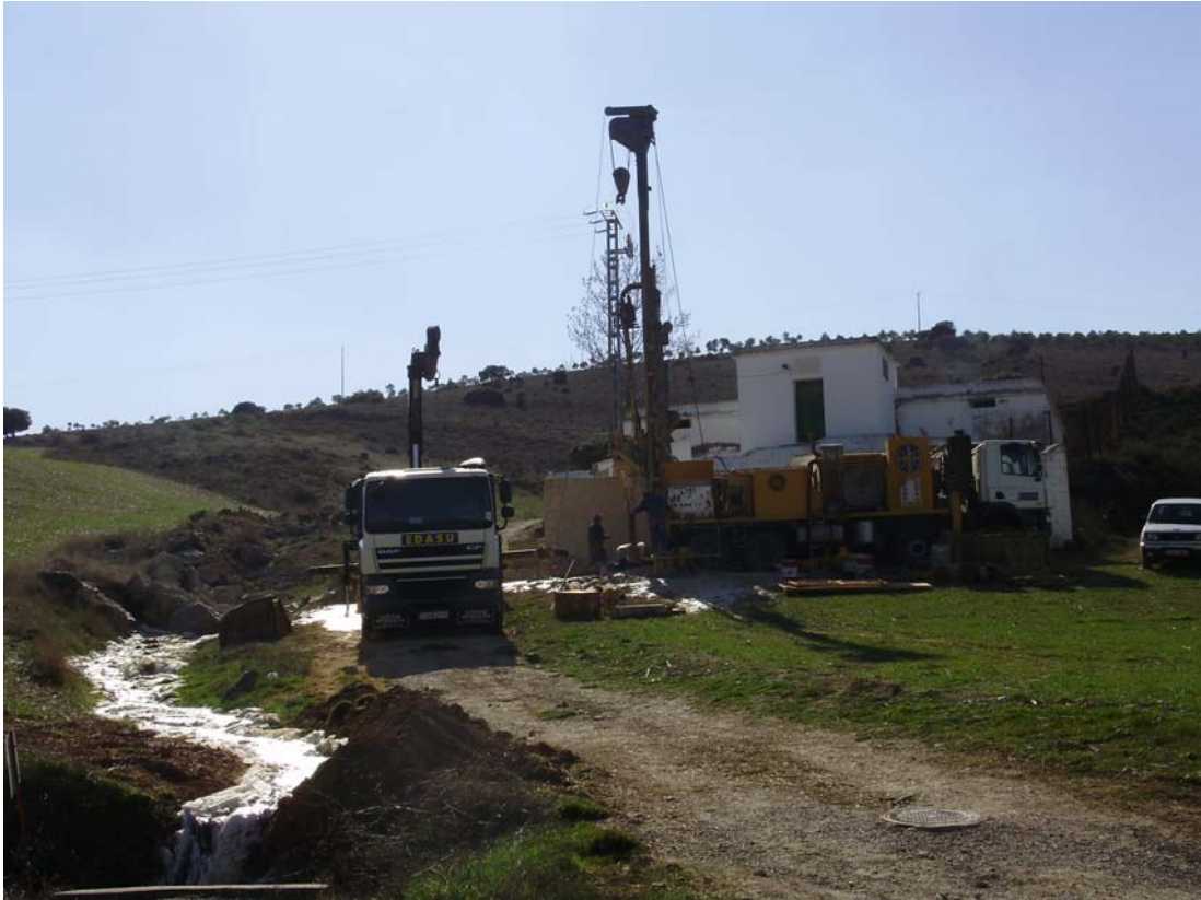
Figura 2 .- Perforación del sondeo Villares II
