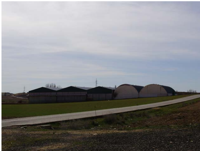
Fig. 8. Focos de contaminación puntual en el entorno de Villares del Saz.
