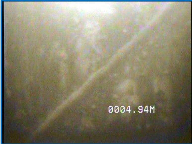
Detalle de soldadura helicoidal, 4,94 m
