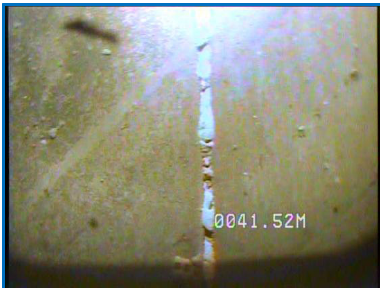
Detalle de ranura e inicio de segunda zona ranurada, 41,52 m
