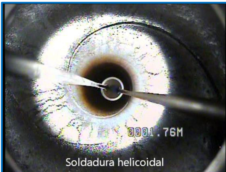
Tubería de acondicionamiento tipo soldadura helicoidal, 1,76 m
