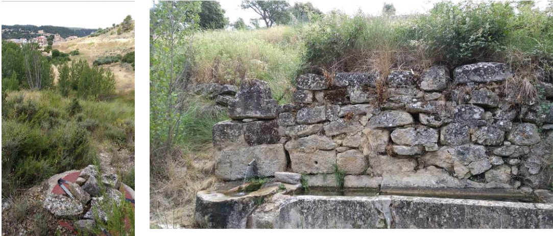
Figura 13. Arqueta de captación (izquierda) y abrevadero (derecha) del manantial Fuente La Calzada
