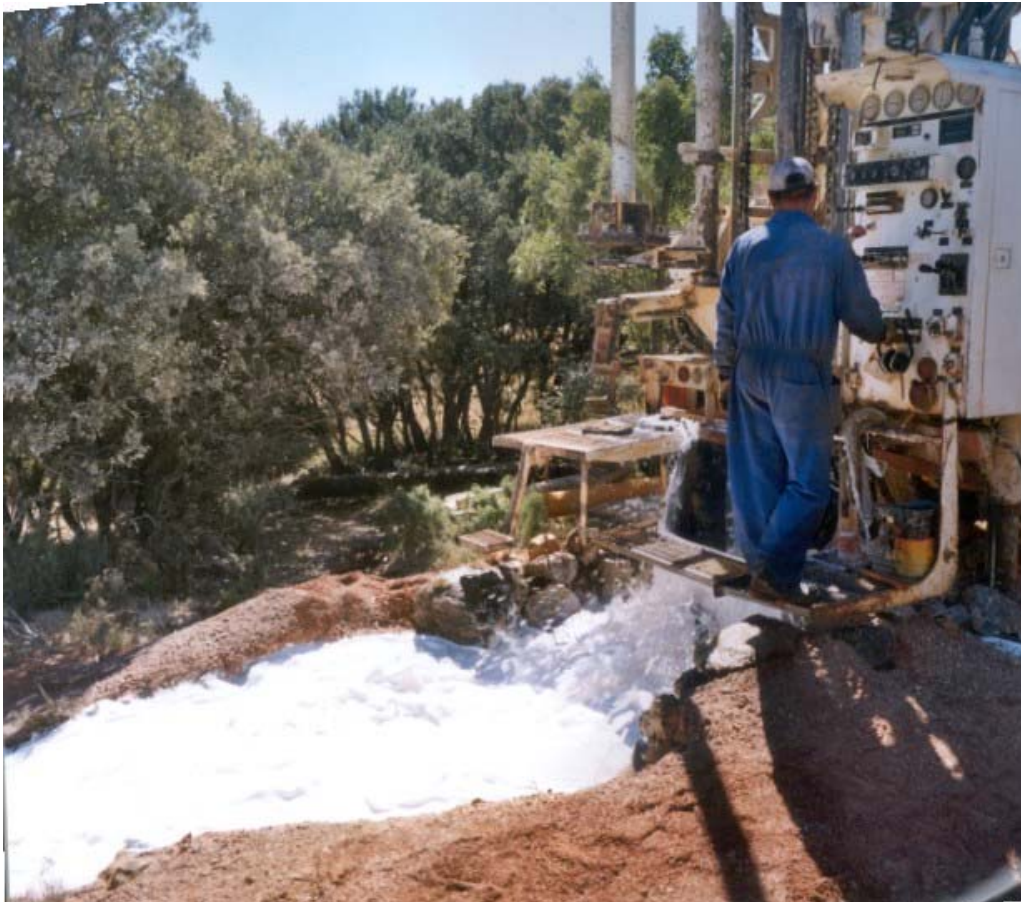
Foto 1. Perforación del sondeo definitivo. Obsérvese el caudal extraído.
